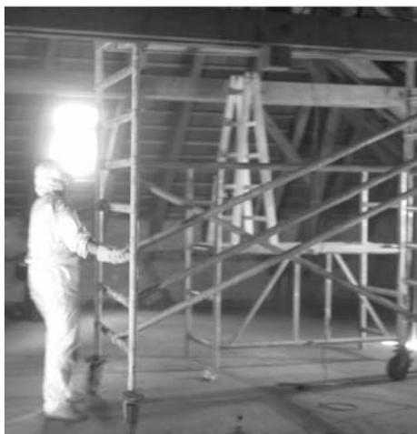
Ein Malergeschäft wurde beauftragt alle sichtbaren alten Balken mit einer speziellen Bürste zu reinigen und diese wie neu aussehen zu lassen. Dies war eine äusserst staubige und mühsame Arbeit. Nachdem alte Holzwände abgebrochen worden waren, konnte mit dem Abbruch der Zwischendecke begonnen werden. Später soll hier der grosse, nach oben offene, Aularaum entstehen.
