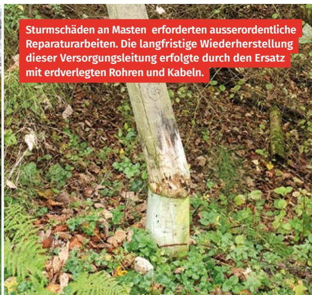
Sturmschäden an Masten erforderten ausserordentliche Reparaturarbeiten. Die langfristige Wiederherstellung dieser Versorgungsleitung erfolgte durch den Ersatz mit erdverlegten Rohren und Kabeln.
