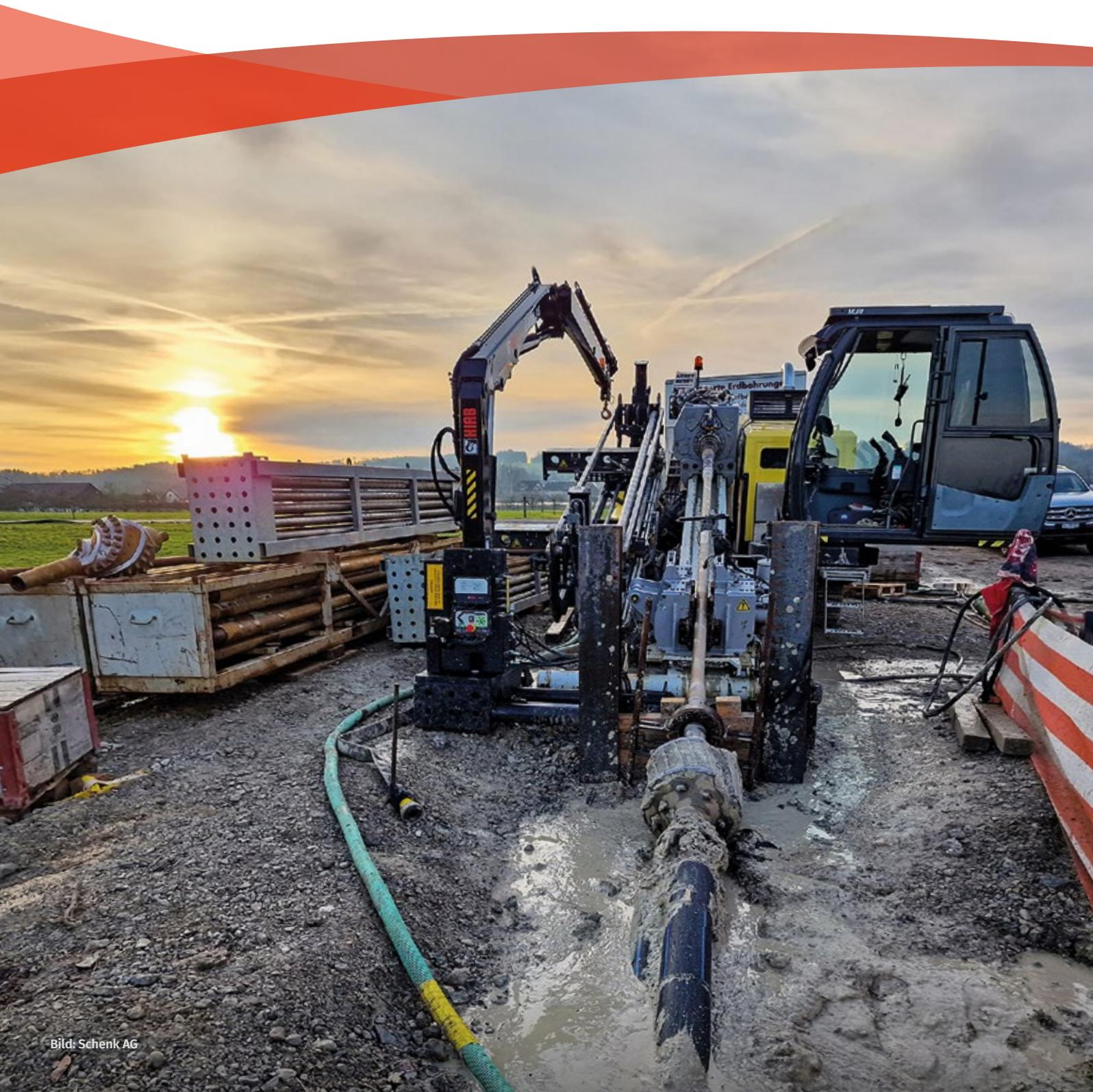
Ein neuer Düker unterquert die Thur im Gebiet Thurfeld-Blumenau – er enthält die Elektrizitäts- und Wasserleitungen.
