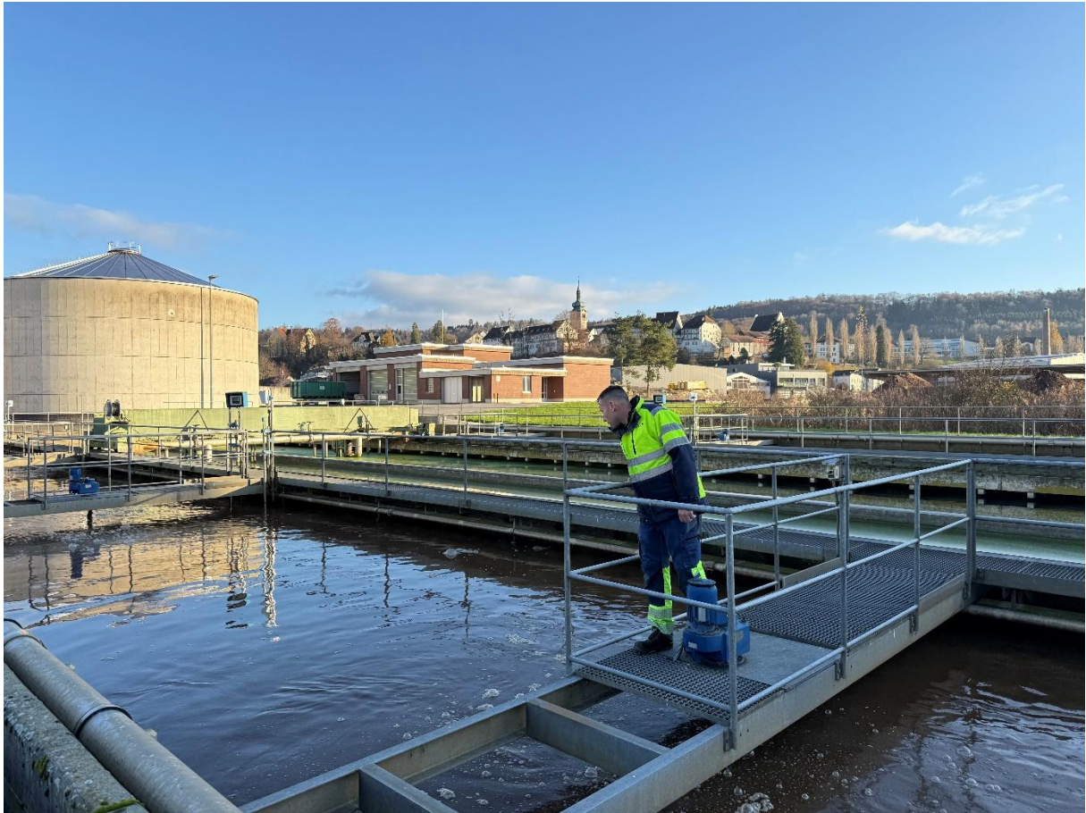
Betriebsleiter Sven Lüthi inspiziert die Kläranlage.
