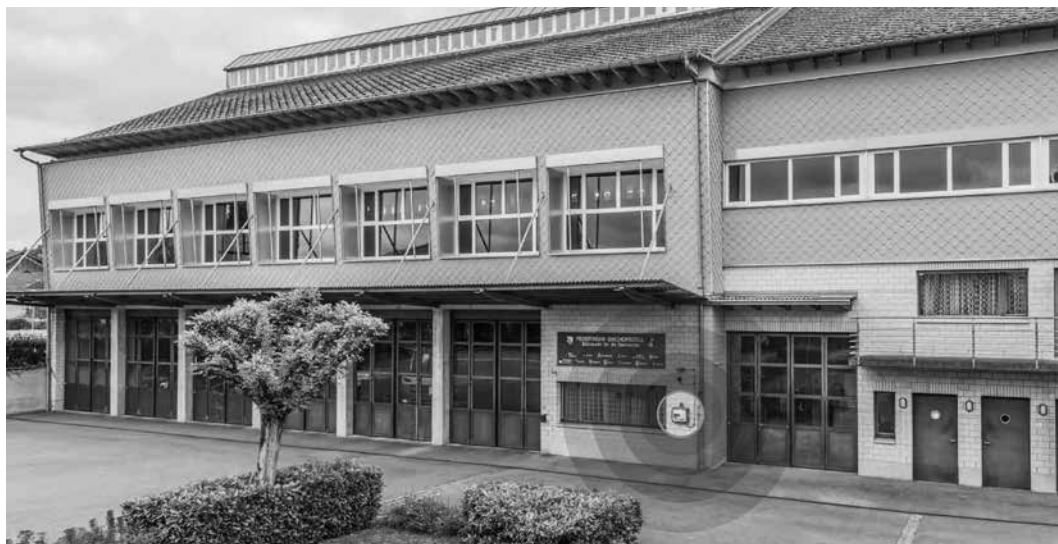
Standort des analogen Notalarms: Turnerweg 2. Die Box ist mit Licht, Bewegungsmelder und Videokamera ausgestattet.
