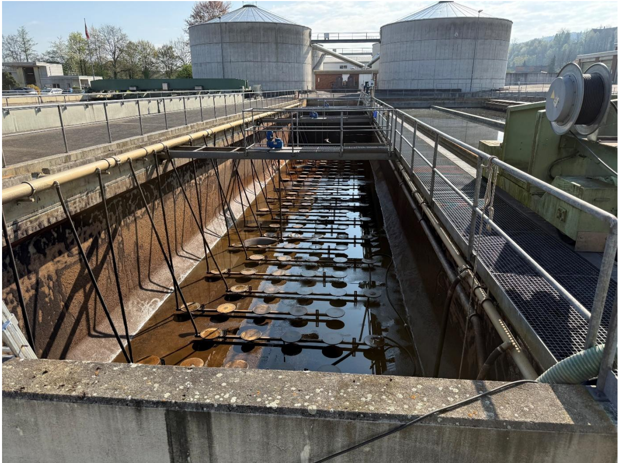
Ein seltenes Bild auf der Anlage: Dieses Klärbecken wurde geleert, damit die Betonwände saniert werden können. (Foto: tw)
