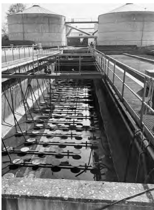
Ein seltenes Bild auf der Anlage: Dieses Klärbecken wurde geleert, damit die Betonwände saniert werden können. (Foto: tw)
