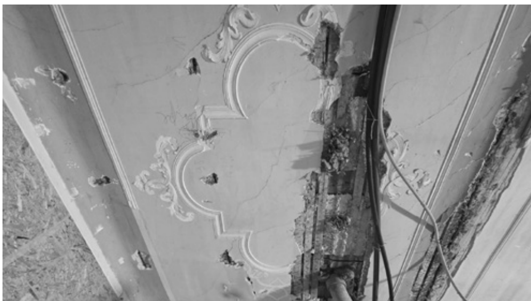
Aktueller Zustand einer Stuckdecke nach Ausbau von Trennwand und Abhängendecke. Die Decke wird zunächst auf Haftung und Schäden geprüft, anschliessend werden Hohlstellen gesichert, Putzfehlstellen mit Kalkmörtel ergänzt, Risse saniert und die fehlende Stuckornamentik rekonstruiert.
